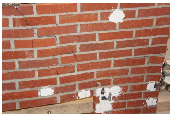
15 pav. Sąramos SR1 suirimo bendras vaizdas
