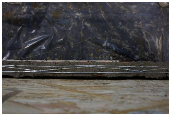
9pav. Gulsčiųjų siūlių armavimo bendras vaizdas
