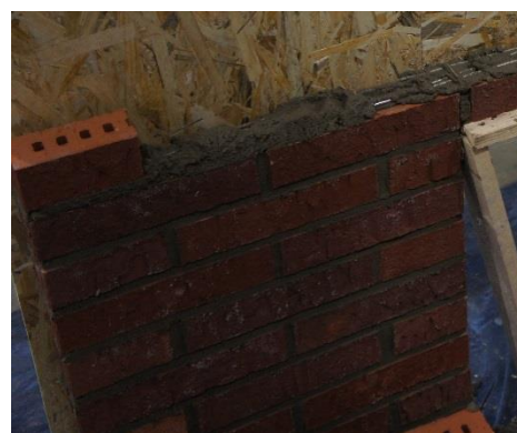
9pav. Gulsčiųjų siūlių armavimo bendras vaizdas
