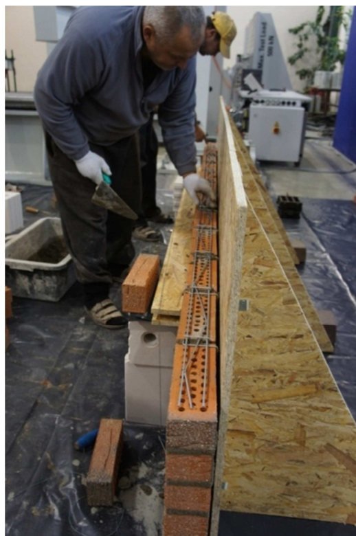
4pav. Gulsčiųjų siūlių armavimo bendras vaizdas
