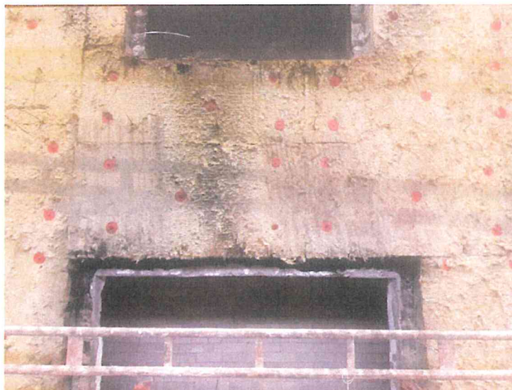
Рис. 10. Внешний вид образца после демонтажа кирпичной кладки.
