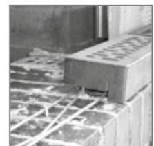
Толщина монтируемой в горизонтальный шов крепежной арматуры в сборе не превышает 10 мм., а с использованием кронштейнов - 12 мм. При размещении арматуры не возникает зримых изменений в толщине шва и ее применение не влияет на общую эстетику кирпичной кладки.
